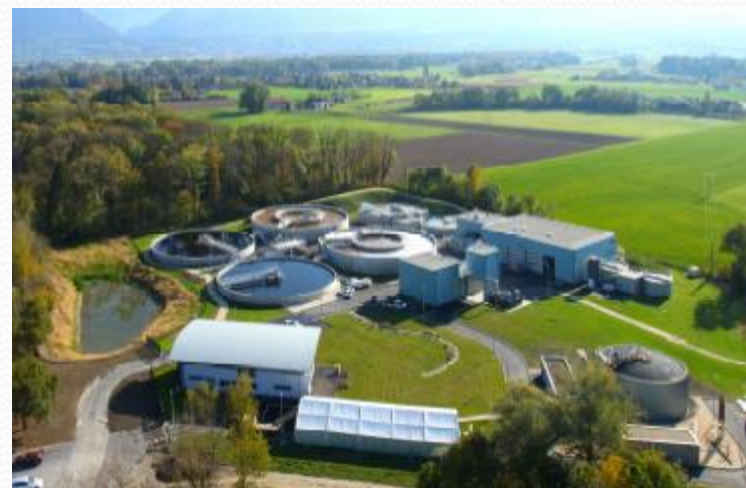
Unité de dépollution ARVEA (source CCPR)
