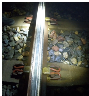
Rail après meulage
