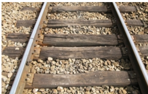
Rails courts sur traverses bois
