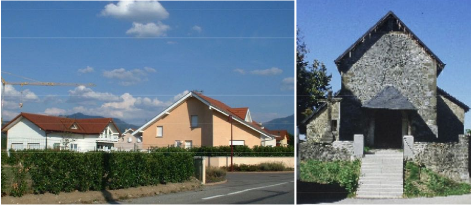
Constructions présentes dans le hameau de Loëx
