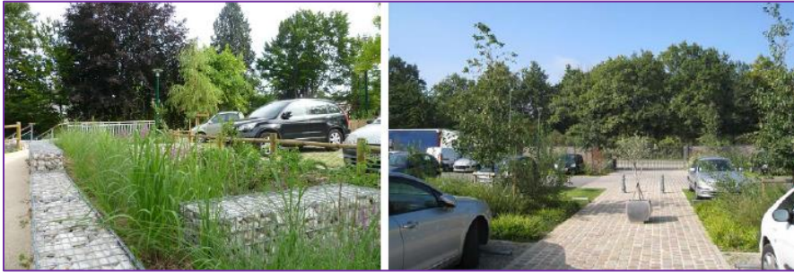
Exemple de stationnements faisant l'objet d'une intégration paysagère et d'un traitement alternatif des eaux pluviales. Source: EPODE
