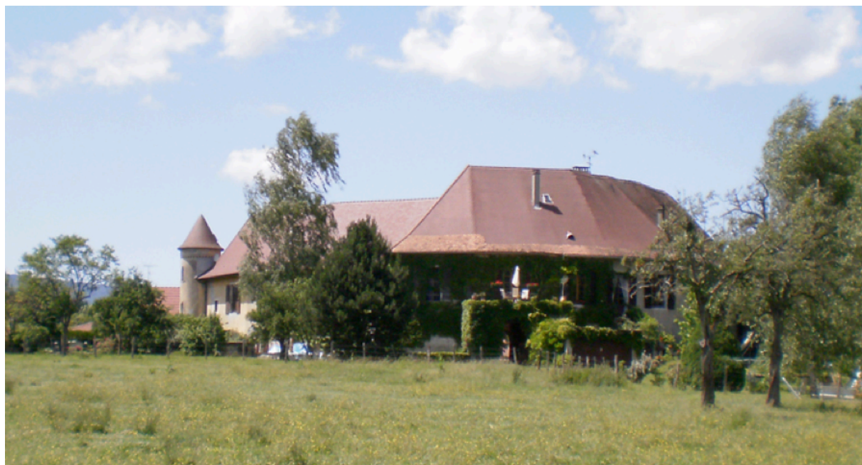
Vue de la façade Est du château
