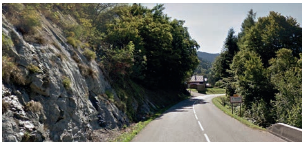
Entrée nord du hameau de La Frasse
