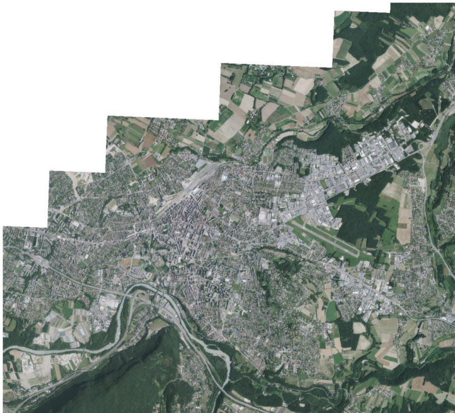
Annemasse sur la période 2010-2021. Source : IGN
