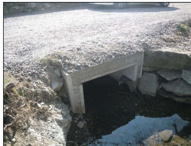
Cadre béton réalisé
