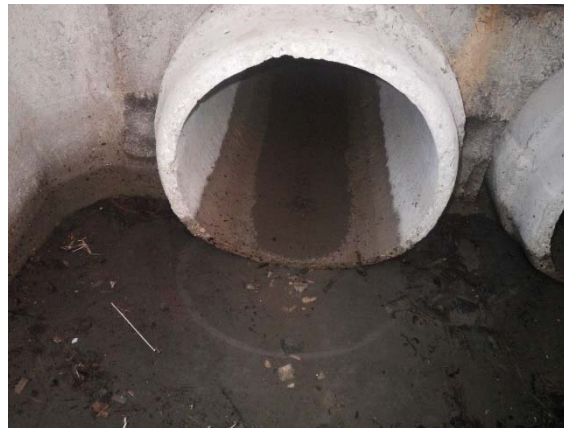
Arrivée des conduites busant le fossé
