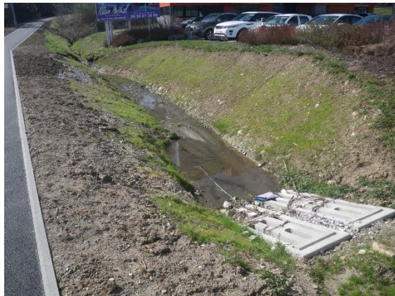
Re-calibrage et entonnement du fossé
