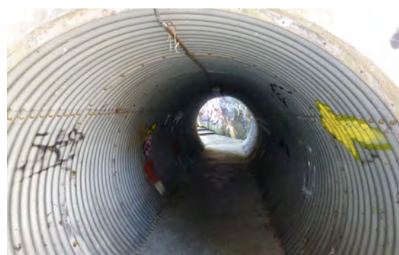
Le passage sous la RD 1203 pour rejoindre La Roche
