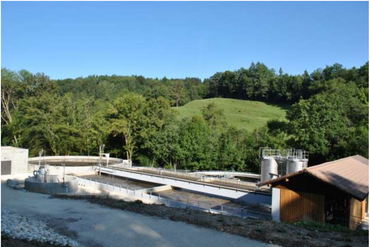
STATION D'EPURATION D'ALLONZIER LA CAILLE
