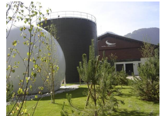
Station d'épuration de la vallée d'Abondance, à filtres biologiques compacts et son méthaniseur.
