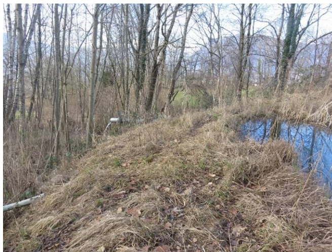
Exutoire du bassin de rétention artificiel
