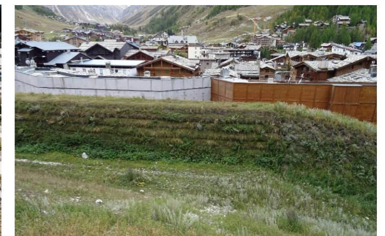
Fig. 5 : « banquettes - merlons » en amont des immeubles du Thovex (photo RTM73).
