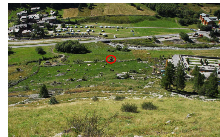
Fig. 6 : blocs issus d'éboulements anciens à l'est du cimetière. En rouge, le bloc de 30 m 3 de la fig. 1 (photo RTM73).
