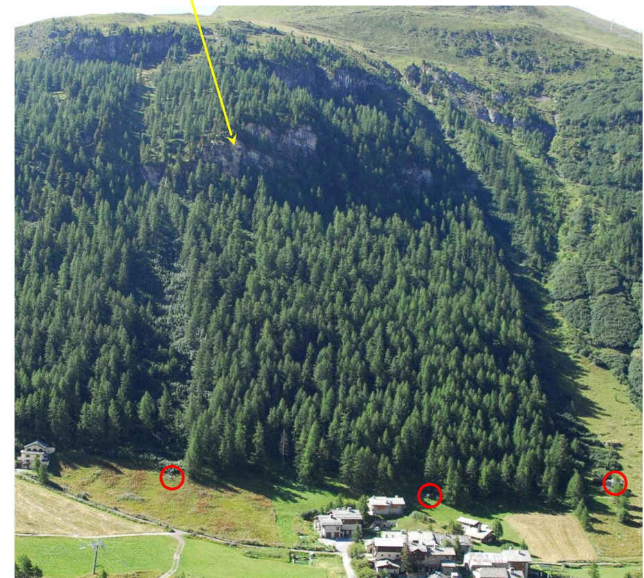
Fig. 1 et 2 : vue générale et rapprochée de la paroi de dolomies en amont du Laisinant (photos RTM73).
