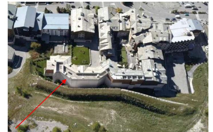
Fig. 2 : "banquettes - merlons" en amont des immeubles du Thovex (trajectoire n°32 CLPA) (photo RTM73).
