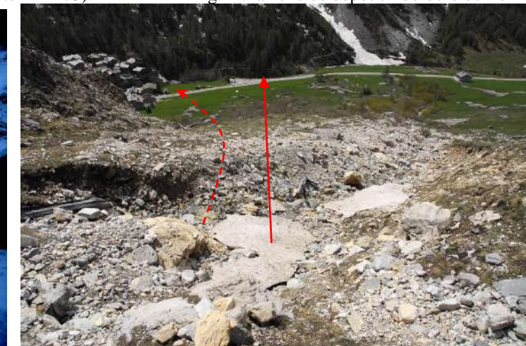
Fig. 3 : dépôt peu épais de l'avalanche du 13/01/04, arrêt dans la fosse du merlon, en bordure ouest du Fornet (photo RTM73).
