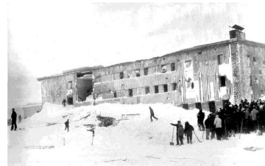
Fig. 4 : couverture du journal "Le Progrès" du 11/02/70, montrant la façade amont de l'UCPA juste après le drame (photo DL). Noter le dépôt de neige d'environ 4 m d'épaisseur contre la façade et les ouvertures soufflées sur 4 niveaux.
