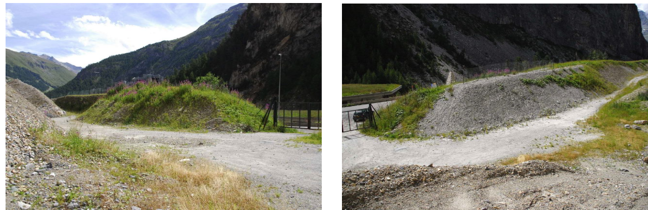
Fig. 3 et 4 : les merlons en remblais protégeant la RD 902 et la partie nord du centre technique municipal (photos RTM73).
