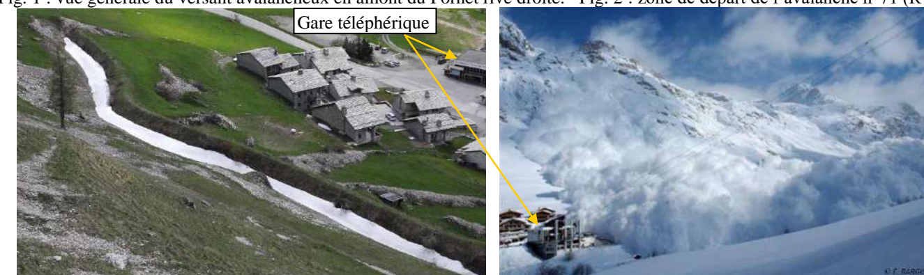
Fig. 3 : le merlon en 2012, avec sa fosse encore à moitié remplie de neige fin mai (RTM73). Fig. 4 : aérosol du 6/03/06 (E. Bargis)
