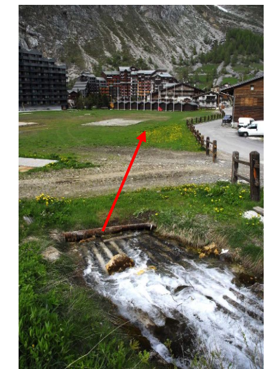
Fig. 4 : à gauche, le pont de la fig. 3 mis en charge lors de la crue décennale de 2010 (photo Mme Biollet). Fig. 5 : à droite, le ruisseau de St Joseph avec l'avaloir et sa grille, juste à l'amont de la gare des télécabines (photo RTM73).
