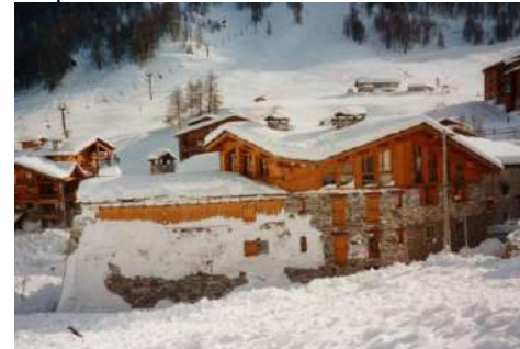
Fig. 4 : plâtrage de la résidence « La Barmaz » en 1991 (ph. Pistes)
