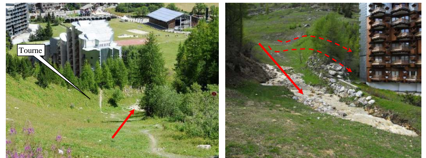
Fig. 3 et 4 : exutoire de la tourne et risque d'embâcle et de débordements majeurs sur l'immeuble du Santel au niveau de l'étranglement (photos RTM)
