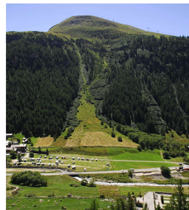
Fig. 3 : vue générale de la combe du Lavancher en 2012.
