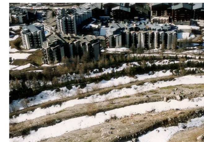
Fig. 5 : « banquettes - merlons » en amont des immeubles du Thovex (photo RTM73).
