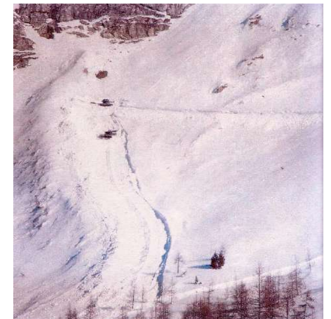
Fig. 2 : La digue de protection de "Pierre et Vacances" (ph. RTM73) Fig. 3 : La tourne dominant la vieille Daille en janvier 2012. Noter le curage en cours de l'ouvrage et les traces de débordement de l'avalanche de décembre 2011 (sce M LEPRIVEY).
