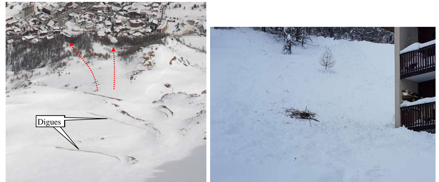
Fig. 6 : les deux digues sous le Rocher de Belvedere, nivelées l'hiver, avec les trajectoires n°14 vers les Greniers de La Balme.
