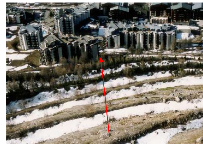
Fig. 2 : "banquettes - merlons" en amont des immeubles du Thovex (trajectoire n°32 CLPA) (photo RTM73).
