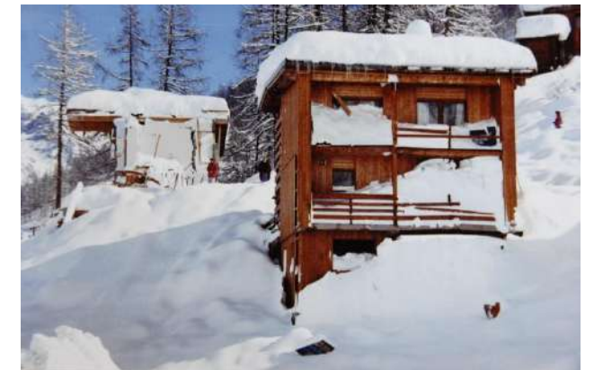
Fig. 8 : chalets du Châtelard endommagés ou détruits par l'avalanche de 1990 (photo : Pistes).
