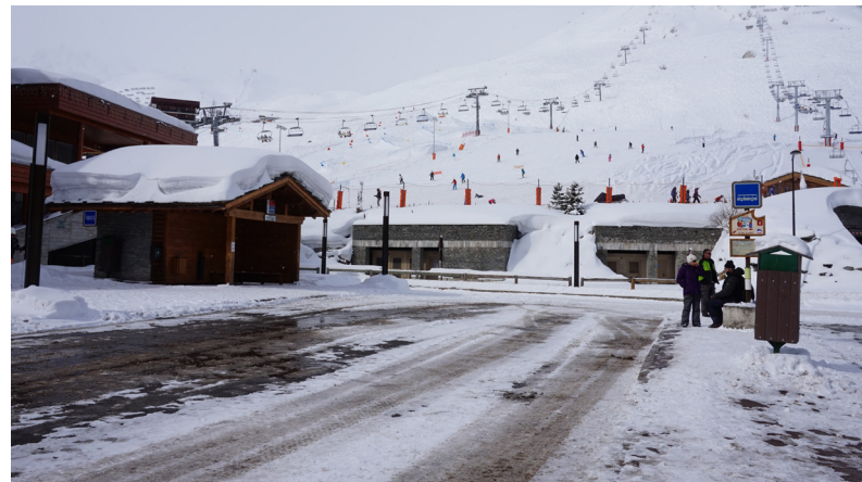
Gare routière (février 2017)
