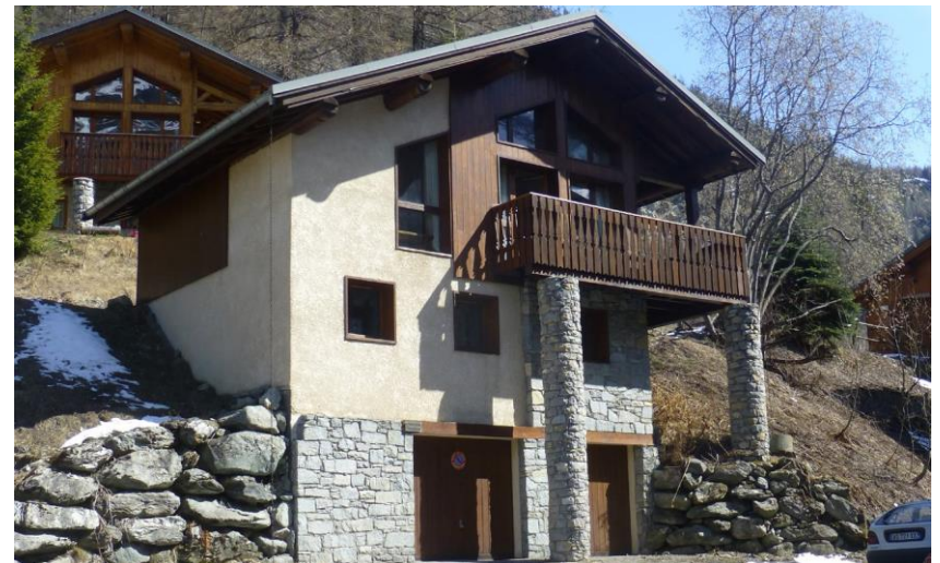
Recours à des matériaux traditionnels : bois en bardage, pierres en soubassement
