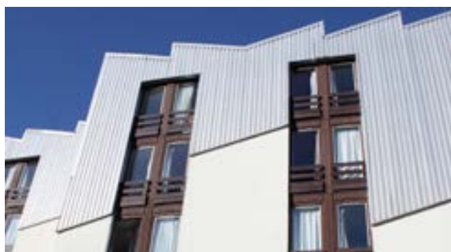
Toiture métallique, CAUE, 2015
