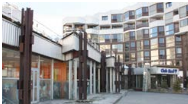
Cours donnant accès au bâtiment, CAUE, 2015
