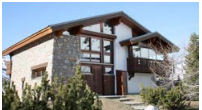
Le Colombéro mélange de bois et de pierre, CAUE, 2015
