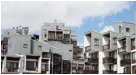
Toits métalliques, CAUE, 2015
