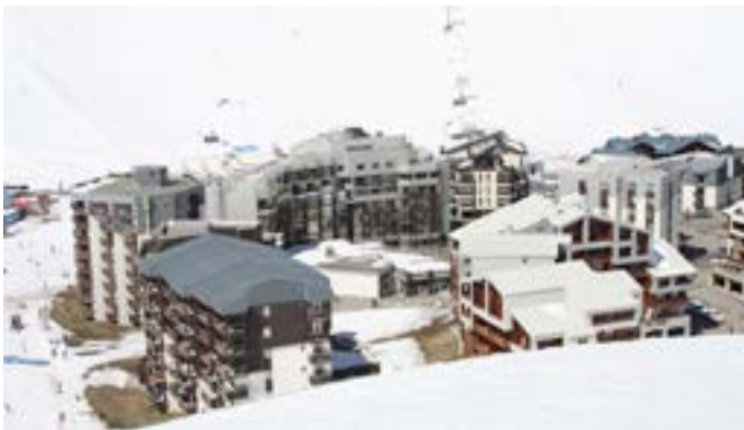
Création de nouvelles toitures sur les toits plats existants, L.Louis, CAUE, 2015
