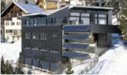
Panneaux photovoltaïques en façade en Suisse, Google image 2015
