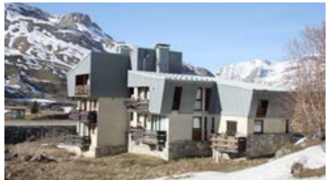
Le Cafetan et ses toitures métalliques, CAUE, 2015
