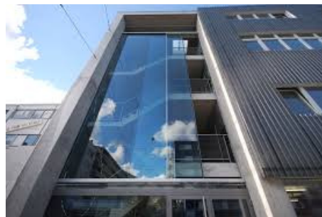
Exemple de façade vitrée, Asder, 2015
