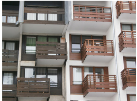
Rénovation au Curling, CAUE, 2015
