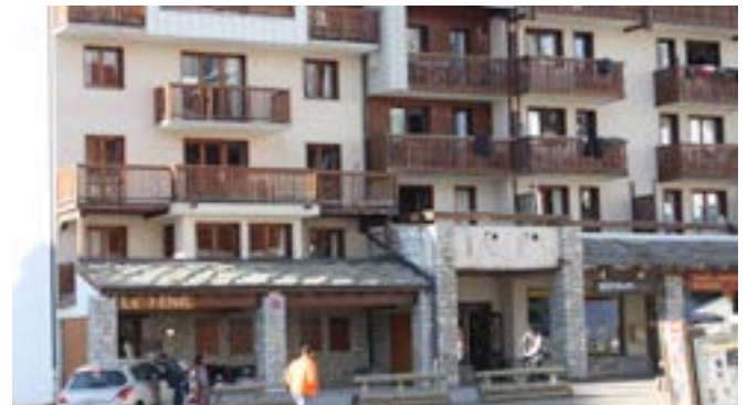
Galerie commerciale en rez-de-chaussée, CAUE, 2015
