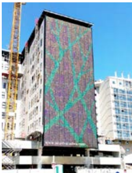
Mur rideau en panneaux photovoltaïques, Jaiuntrucadire.com, 2015
