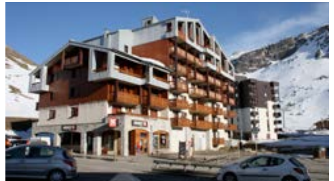
Mélange de bois et de métal, CAUE, 2015
