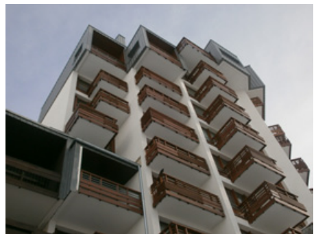
Rénovation au Curling, CAUE, 2015
