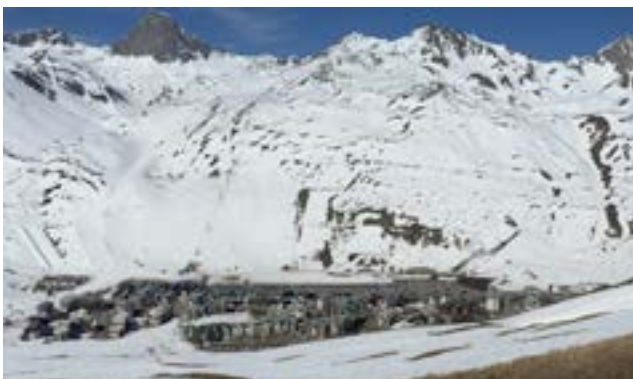
Vue du Val Claret depuis le versant est, CAUE, 2015
