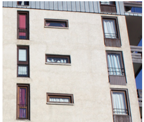
Exemple de menuiseries bois présentes au Val Claret, CAUE, 2015
