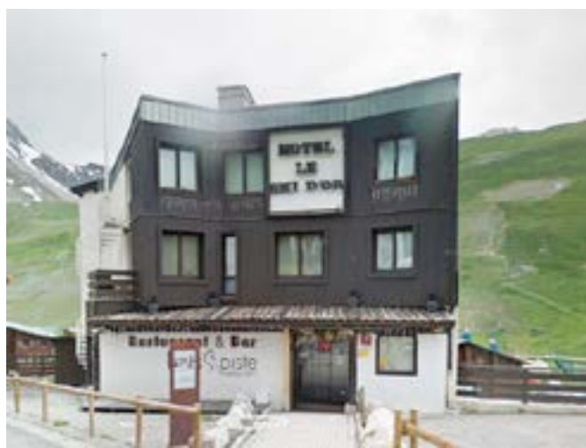
Entrée faite de bois et couronne métallique, et escalier de secours, CAUE, 2015
