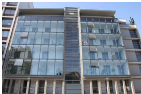
Double peau vitrée à Chambéry, immeuble d'habitations, CAUE, 2015
