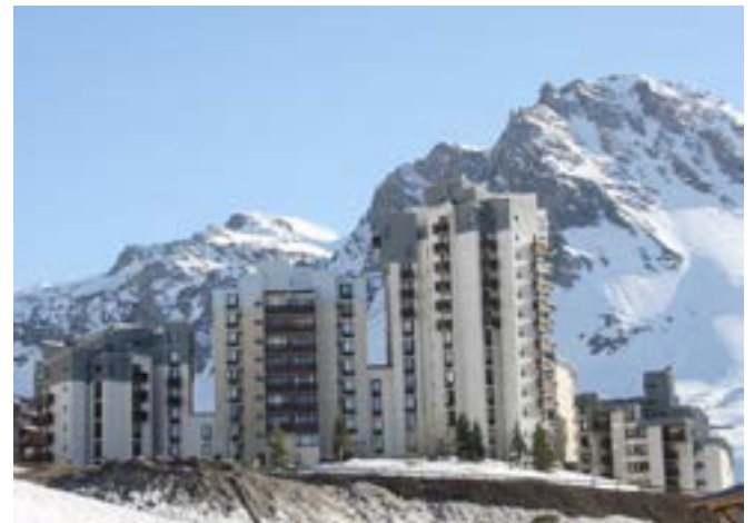
Toitures brisées et façades plurielles, CAUE, 2015
