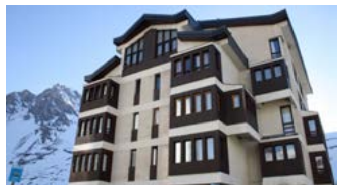
Bords de toiture retroussés, CAUE, 2015
