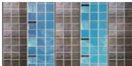
Photovoltaïque sur façade ventilée, Archi expo, 2015
