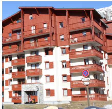
Bois de la Laye, CAUE, 2015
