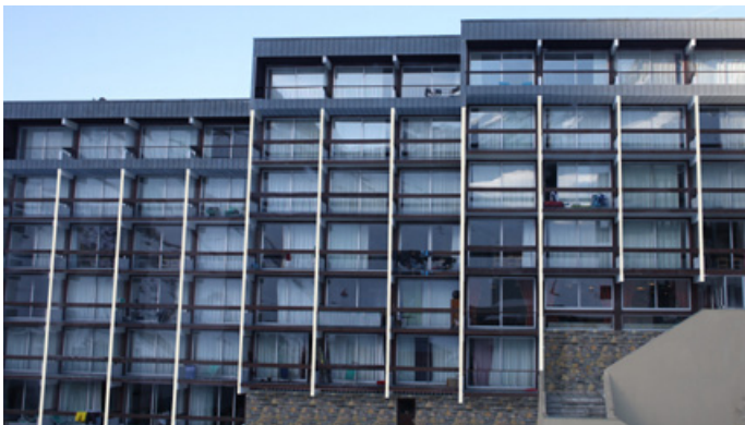
Mise en avant des éléments verticaux et des gardes corps, L.Louis, 2015
