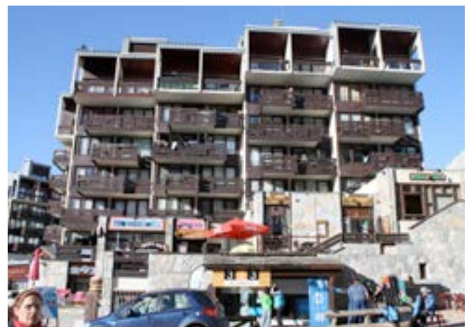
Menuiseries et encadrement bois, CAUE, 2015
