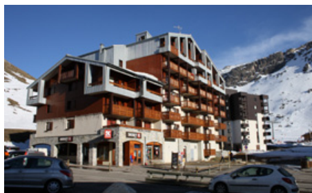
Peu d'aménagements pour piétons et vélos, CAUE, 2015
