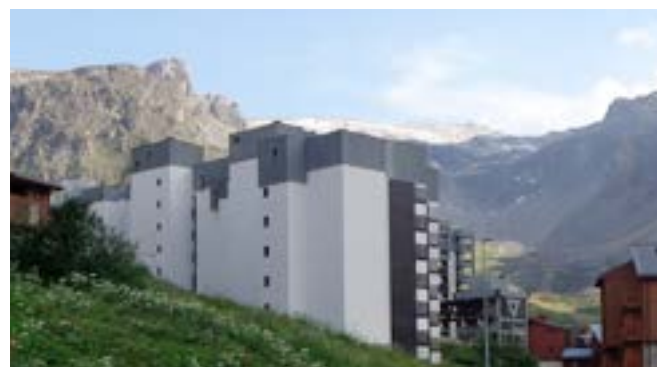
Façade nord opaque, CAUE, 2015
