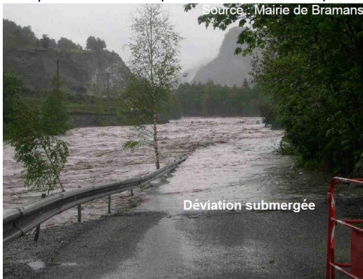
Déviation mise en place pour la réfection de la RD 1006 traversant Bramans inondée
