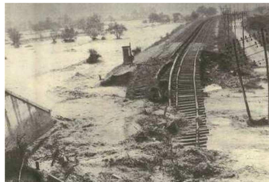
Destruction de la voie ferrée Chambéry-Modane
