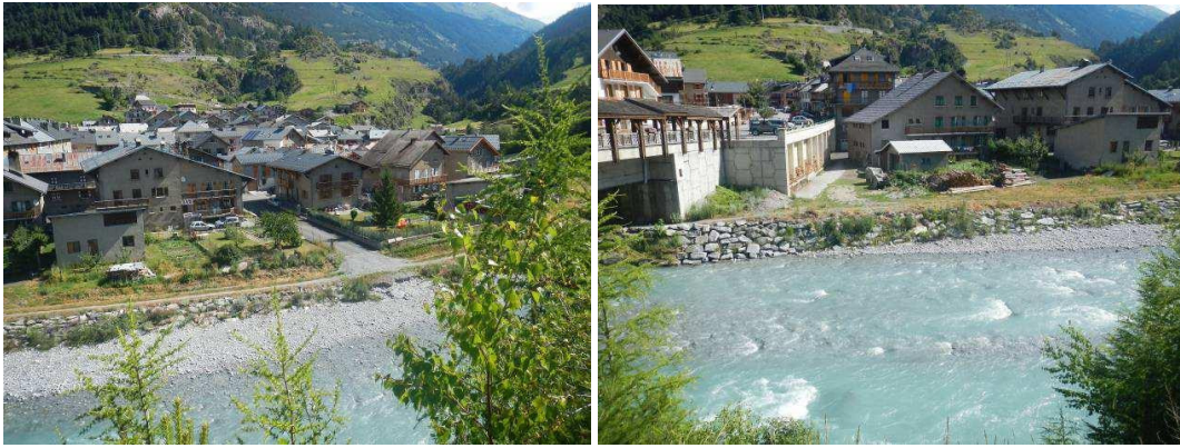
Berges basses en rive droite en amont du pont du Va
