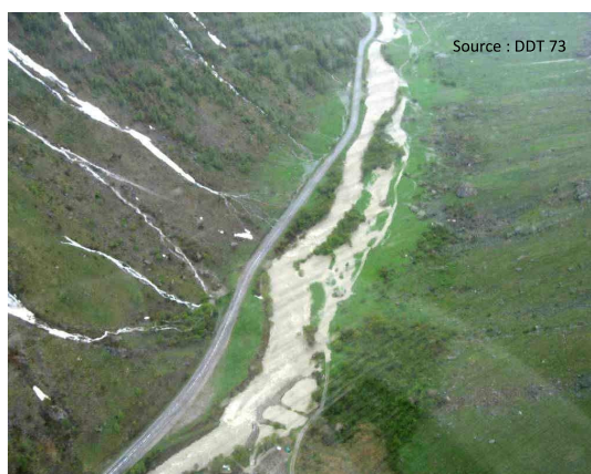
Aval de Bonneval sur Arc
