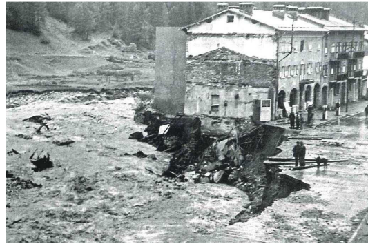
A Lanslebourg, route et bâtiments sont emportés
