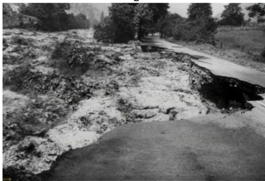
L'Arc en crue au niveau de la RN6 vers Pontamafrey
