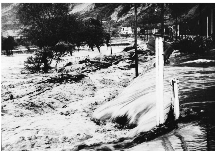
La brèche dite « du pont des Reisses » sur l'Arc au Km 212.377.
