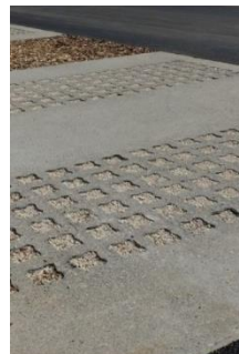
Béton alvéolaire avec un remplissage gravillonné
