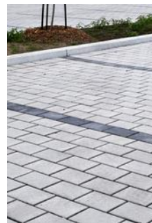
Les pavés drainants
