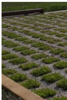
Béton alvéolaire avec un remplissage végétalisé
