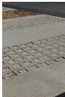
Béton alvéolaire avec un remplissage gravillonné
