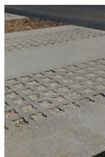
Béton alvéolaire avec un remplissage gravillonné
