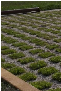
Béton alvéolaire avec un remplissage végétalisé
