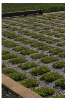
Béton alvéolaire avec un remplissage végétalisé
