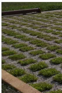
Béton alvéolaire avec un remplissage végétalisé
