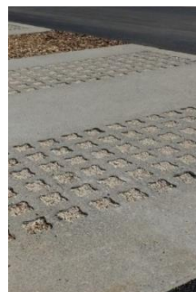
Béton alvéolaire avec un remplissage gravillonné
