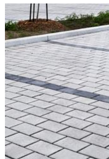
Les pavés drainants
