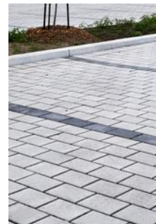
Les pavés drainants
