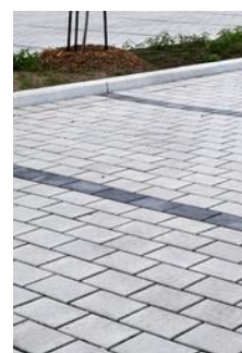
Les pavés drainants
