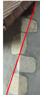
Enduit en surépaisseur des pierres d'angle
