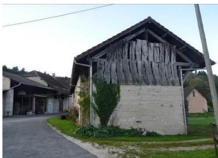
bardage bois en partie haute des annexes agricoles, bois naturel, grisant en vieillissant
