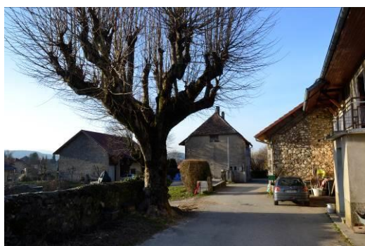
alignement du bâti sur la voie
