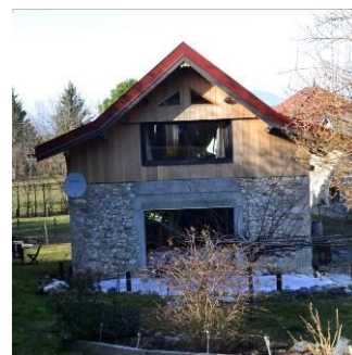
ouvertures créées dans la symétrie du pignon
