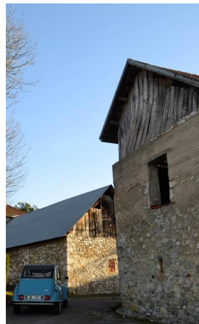
bardage bois en partie haute des annexes agricoles, bois naturel, grisant en vieillissant
