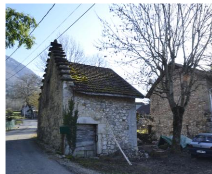
pignon « en pas de moineau »
