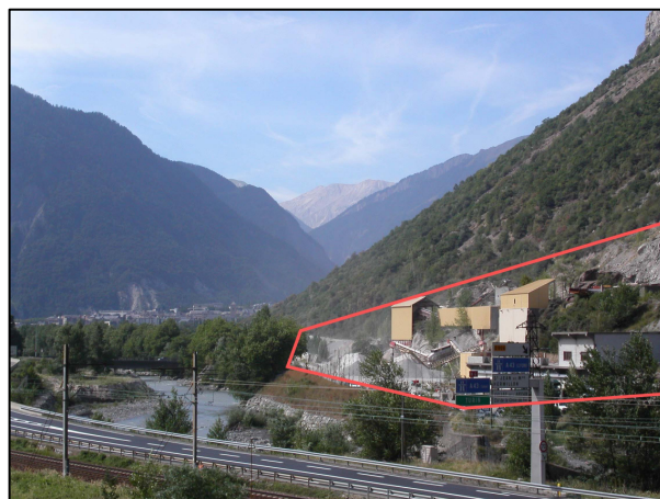
Entrée nord : impact de la carrière dans le paysage
