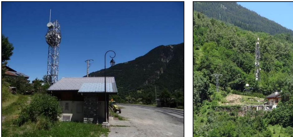
Photo 28 : Antennes dans le paysage
