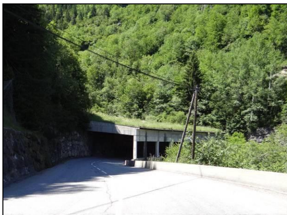
Photo 25 : Semi-tunnel paravalanche sur le D 117
