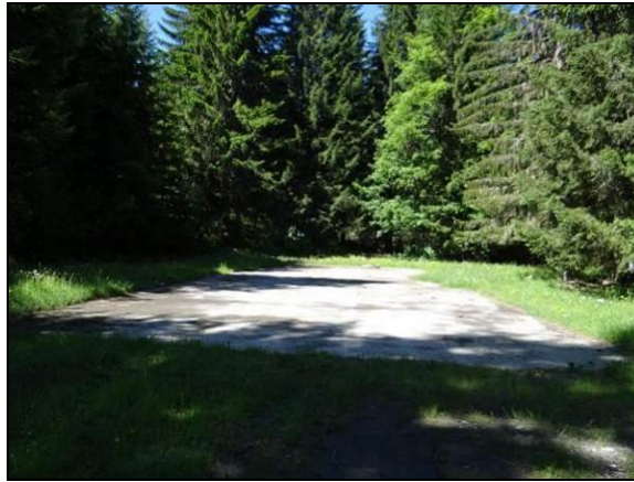
Photo 49 : Dalle béton en forêt de Longefrasse
