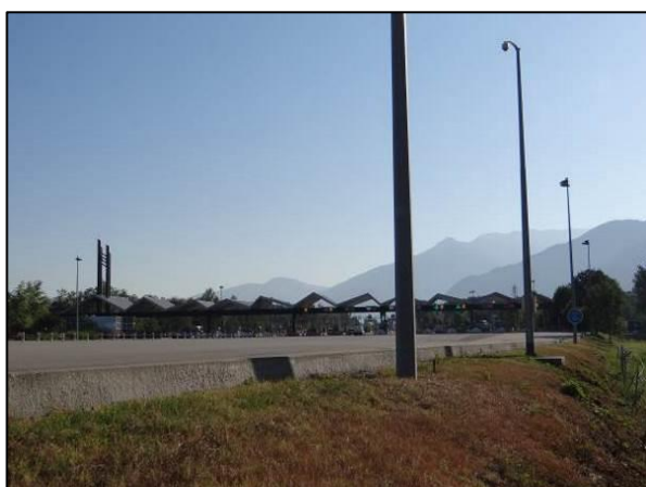
Photo 15 : Péage de Sainte-Hélène-sur-Isère
