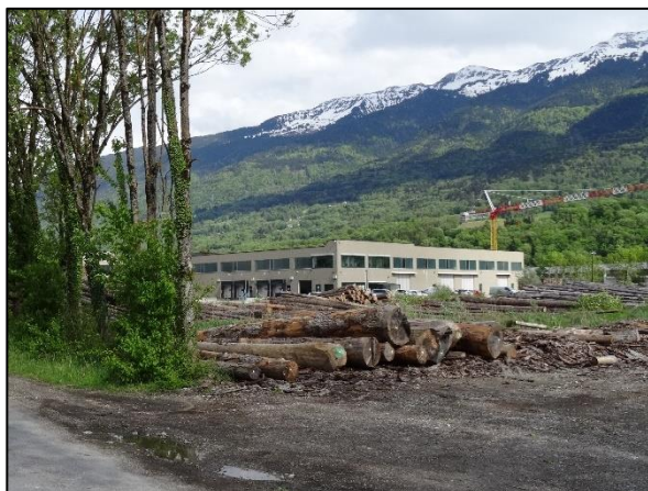
Photo 11 : Bâtiments présents sur la zone d'activité
