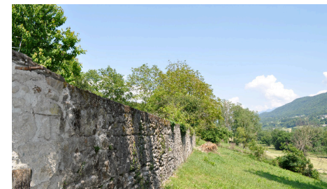
MUR DE PIERRE EN AVAL DU TOUVET
