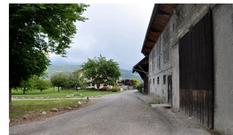
BÂTIMENT AGRICOLE À MONTMEILLERAT
