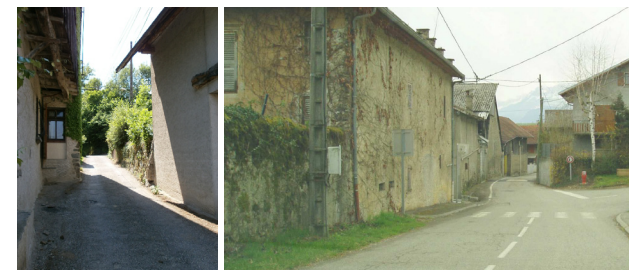
MURS EN BORDURE DES VOIES AU TOUVET ET AU POGNIENT
