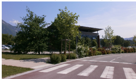
ESPACE PUBLIC ET BÂTIMENT D'ACTIVITÉ
