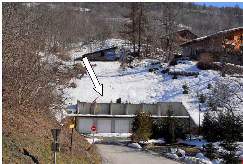
Figure III-24 : garages du Villard situés en contrebas de la RD 902, également exposés à l'avalanche centennale de l'Arpettaz. Source : RTM 2015.
