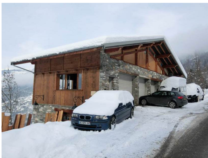
Figure III-21 : vue du chalet – atelier mécanique de Raffort en zone exposée à l'avalanche centennale de l'Arpettaz. Source : RTM 2015.
