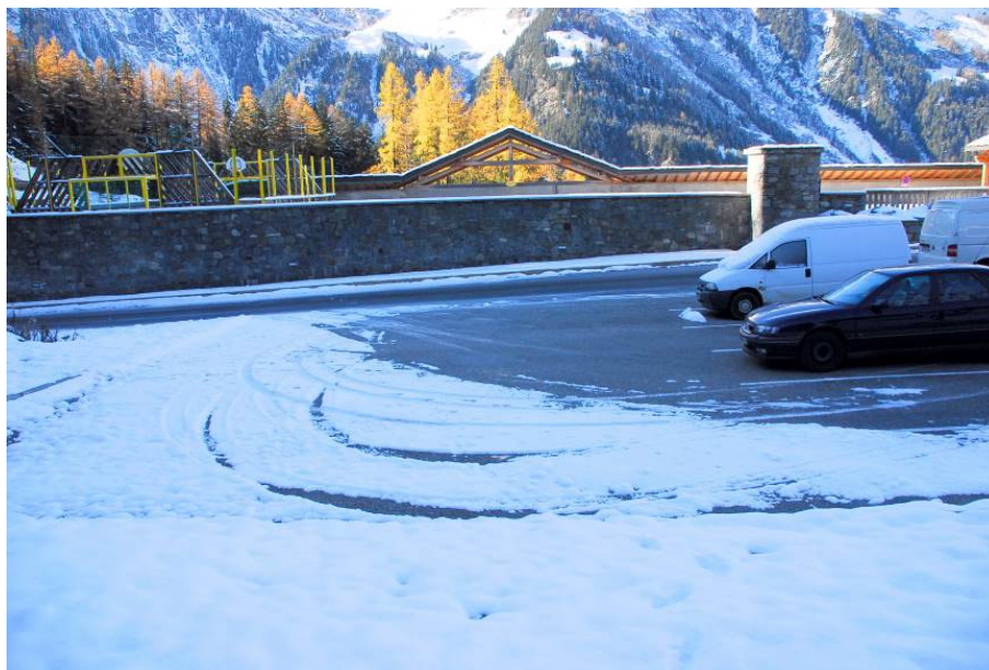
Figure III-17 : vue de la zone d'arrêt de l'avalanche centennale de Bon Conseil, sur le replat en amont du parking couvert. Le mur n'est pas pris en compte dans la simulation mais sera probablement très efficace pour arrêter l'avalanche. Source : RTM 2014.
