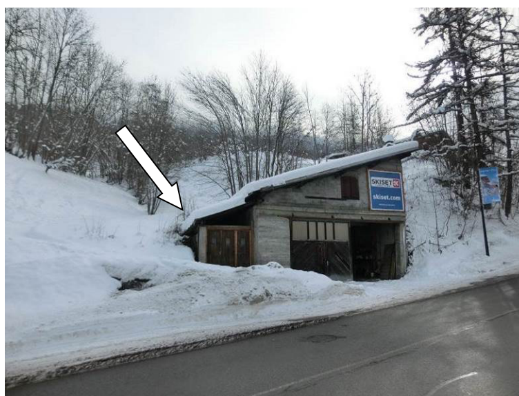
Figure III-23 : vue du garage du Villard situé le long de la RD 902, en zone exposée à l'avalanche centennale de l'Arpettaz. Source : RTM 2015.
