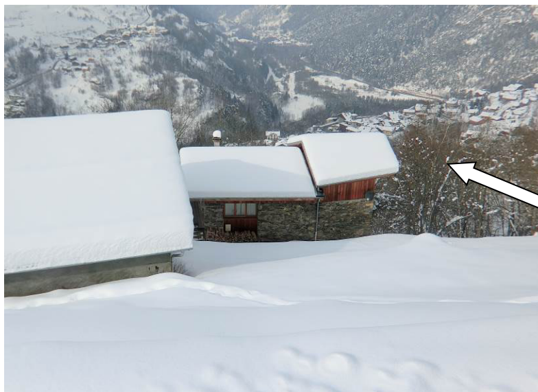
Figure III-22 : vue du vieux chalet situé en extrémité nord de Raffort, sous l'atelier mécanique. L'avalanche de l'Arpettaz peut le frôler par le nord. Source : RTM 2015.
