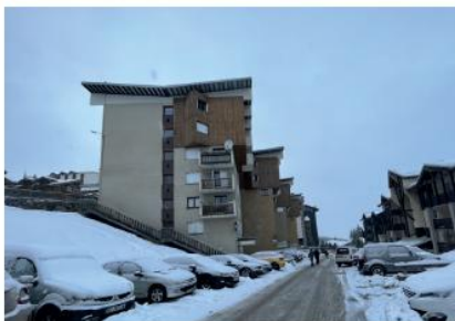
BÂTIMENT CÔTÉ RUE DES LUGEURS (NORD)
