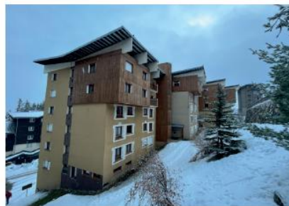
BÂTIMENT CÔTÉ RUE DES TOVETS (SUD)
