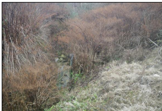
Incision importante et instabilité des berges en aval du tronçon artificialisé
