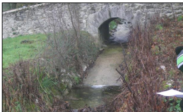
Aval de l'ouvrage de franchissement du chemin des Contrebandiers
