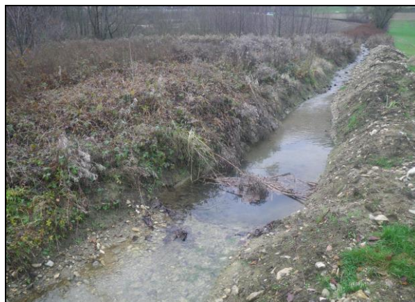
Endiguement du lit par les dépôts de curage
