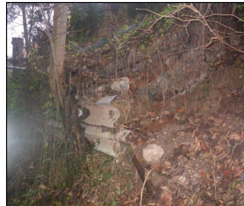
Aménagement de retenue des berges
