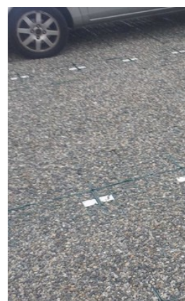
Les dalles alvéolées avec un remplissage gravillonné
