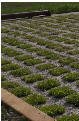
Béton alvéolaire avec un remplissage végétalisé
