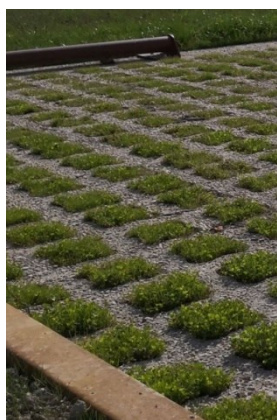
Béton alvéolaire avec un remplissage végétalisé
