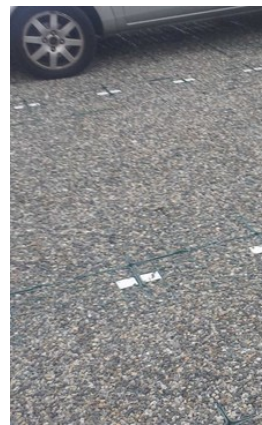
Les dalles alvéolées avec un remplissage gravillonné
