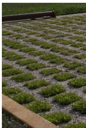
Béton alvéolaire avec un remplissage végétalisé
