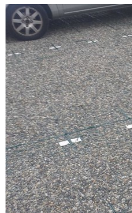
Les dalles alvéolées avec un remplissage gravillonné
