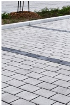
Les pavés drainants
