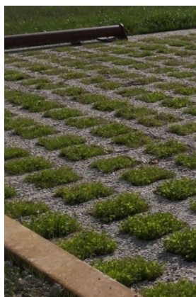
Béton alvéolaire avec un remplissage végétalisé
