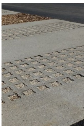
Béton alvéolaire avec un remplissage gravillonné
