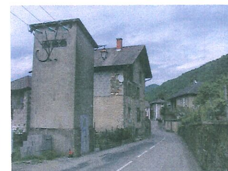
point "noir" : transformateur à l'entrée Sud du chef-lieu
