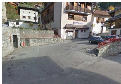
Peu d'espaces piétons mais une voirie élargie
