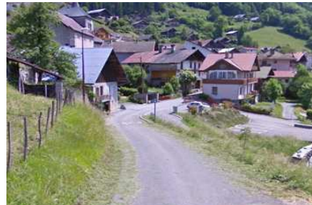
Une voirie communale dédiée à la voiture
