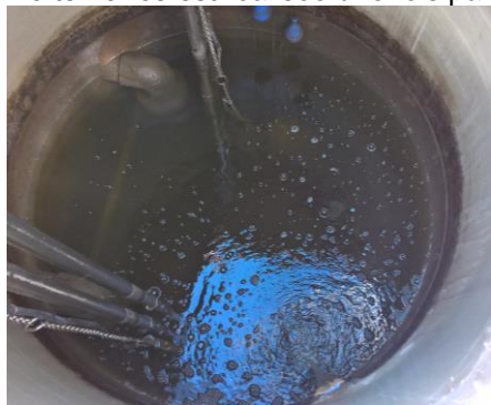
Poste alimentant le 2 ème étage
