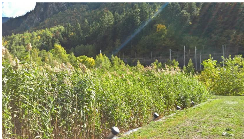
Photo ci-contre : 1 er étage du filtre planté de roseaux, bassin 2, partie côté Arc.
