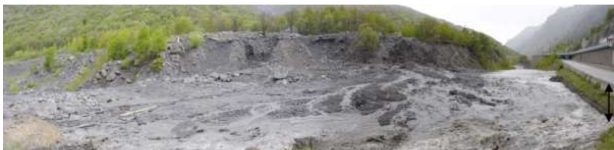
Zone de confluence du torrent du Poucet avec l'Arc, 02/05/2013, photo RTM
