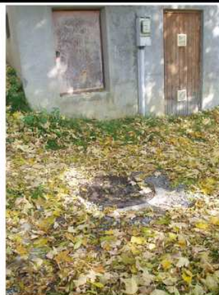
Poste de comptage
