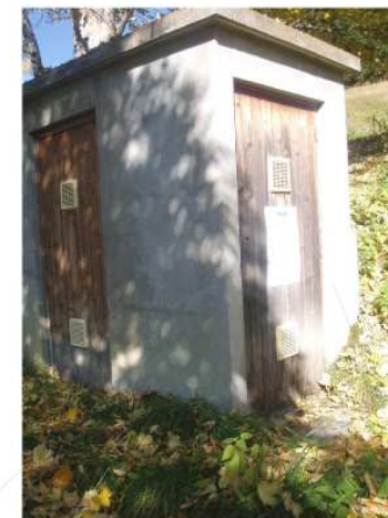
Poste de chloration
