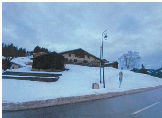
Bâtiment 6 - parcelle C606
