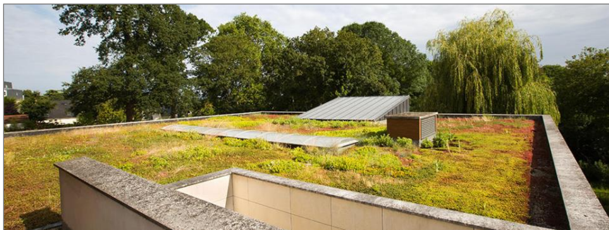
Acrotère sur un toit-terrasse végétalisé
