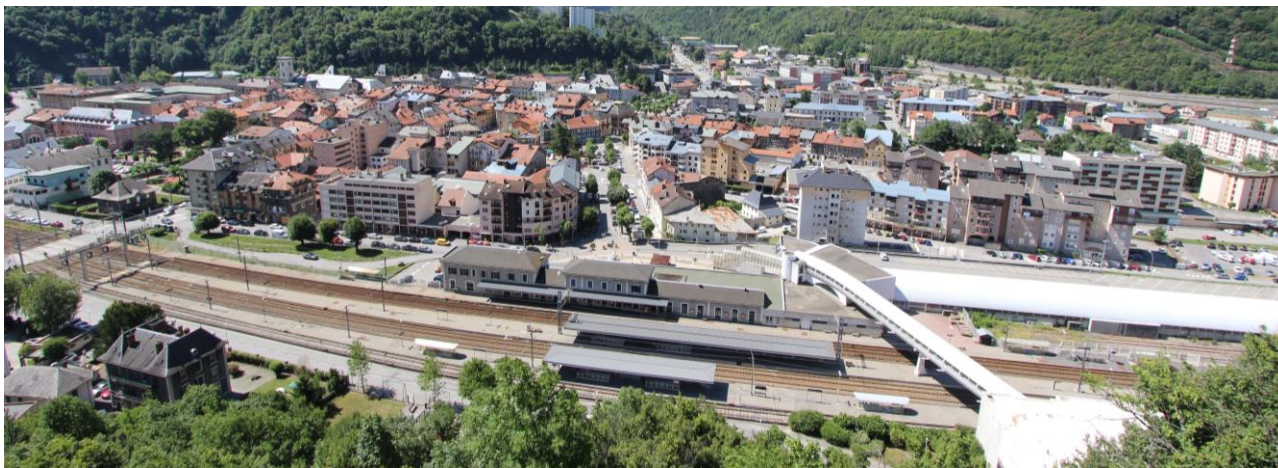
La gare SNCF, avec la passerelle permettant de traverser les voies vers la Chaudanne – vue vers le sud
