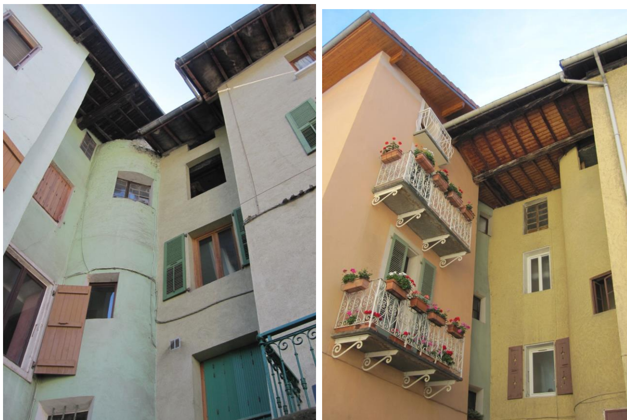
Couleurs variées, petites ouvertures et grands débords de toits sur les façades secondaires
