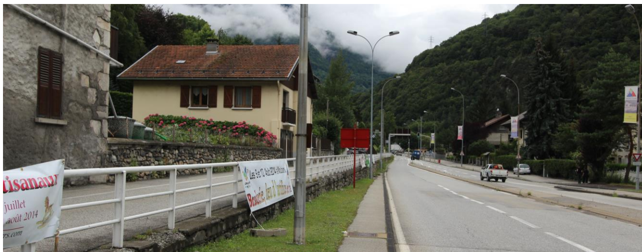
Avenue de Salins, RD 1095 dans le sens de la sortie vers Salins-les-Thermes
