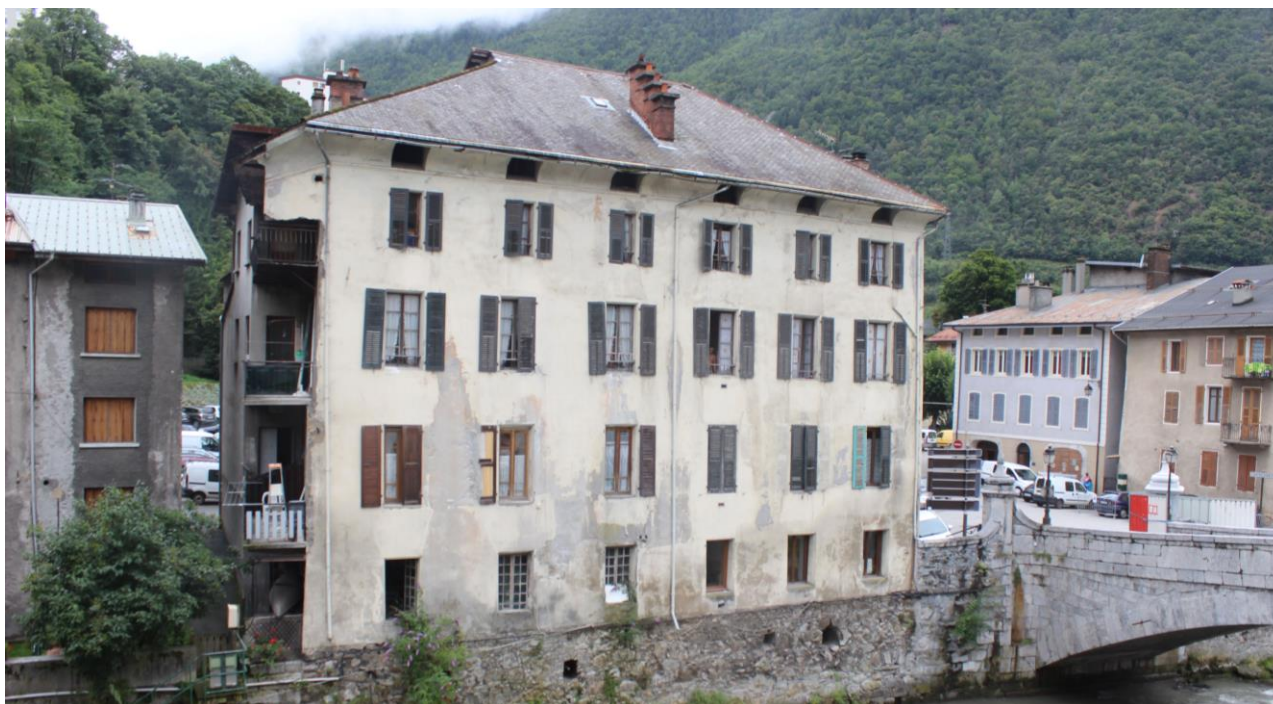
Bâtiments non contigus en rive gauche de l'Isère
