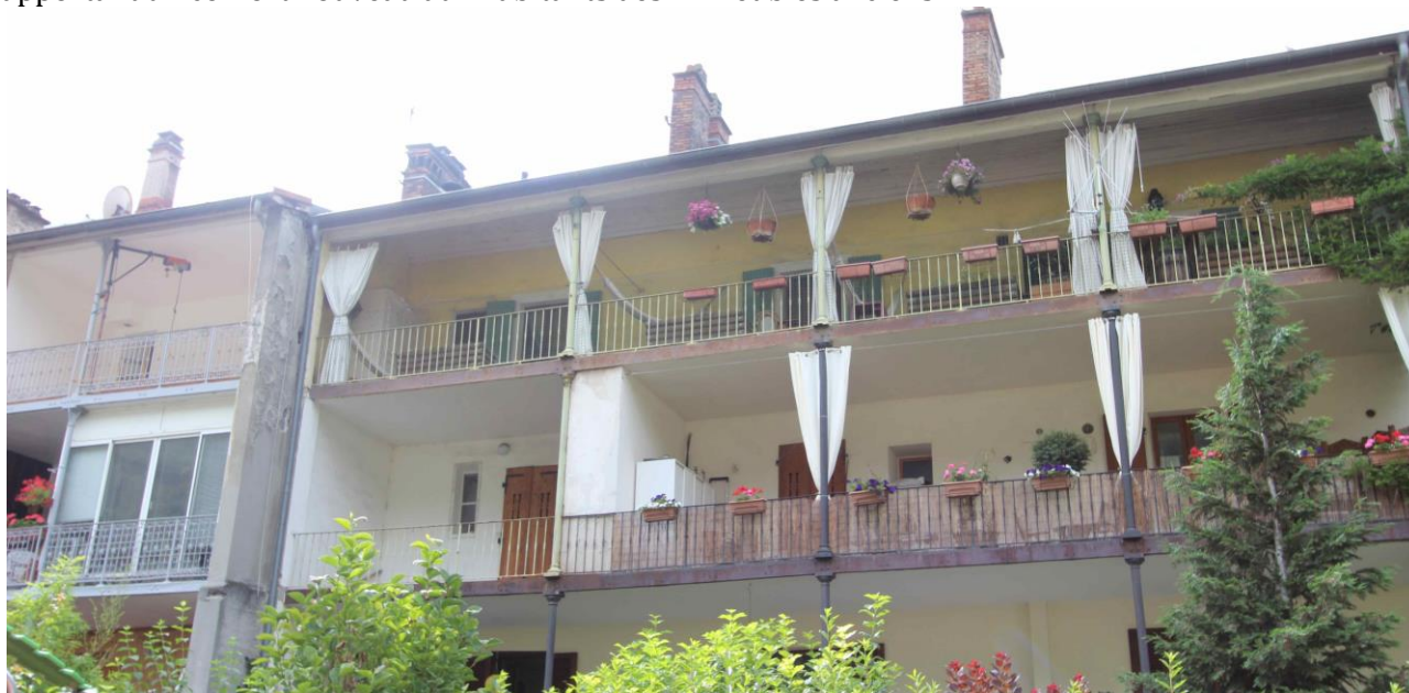
Loggias continues sur toute la longueur d'une façade sur cour
