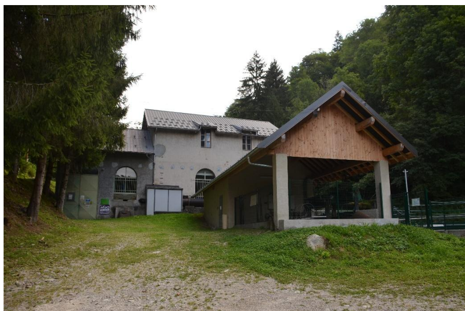
Microcentrale électrique de Montsapey le long du ruisseau de Basmont en aval du Moulin alimentée par six prises d'eau :
