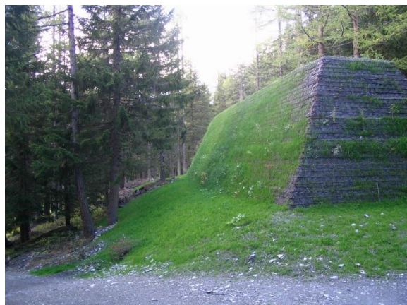
Exemples de merlons végétalisés à parements raidis (ici la hauteur est de 6 à 8 m)
