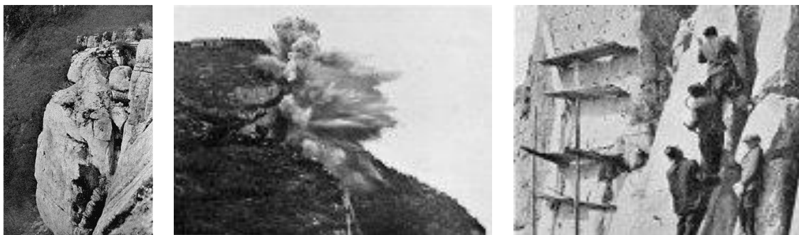
Les travaux de 1913
