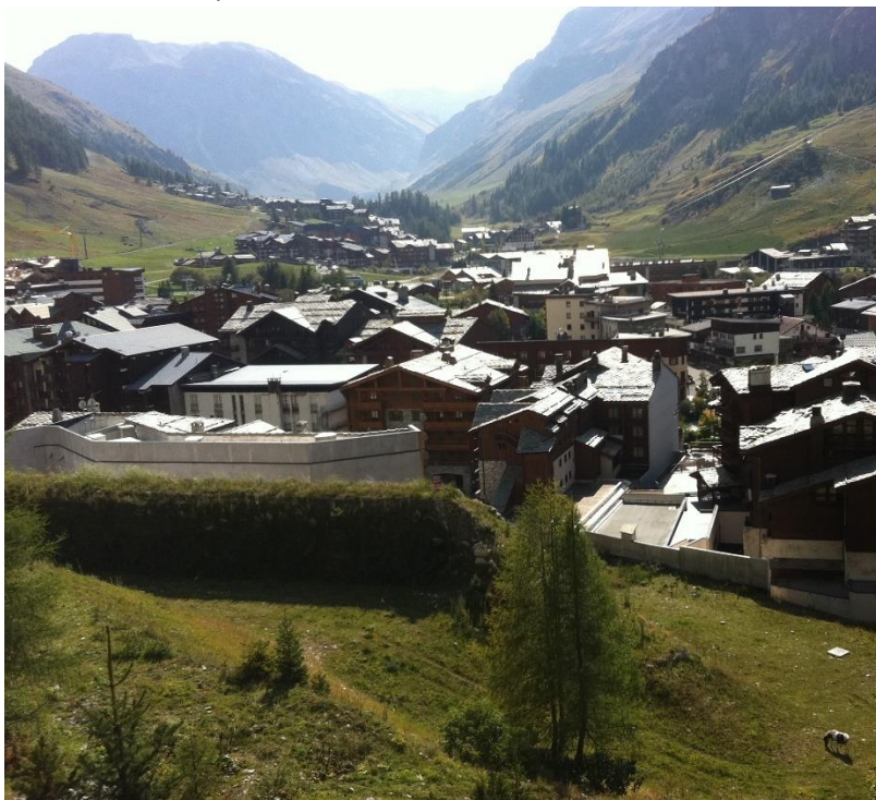
Exemples de merlons végétalisés à parements raidis (ici la hauteur est de 6 à 8 m)
