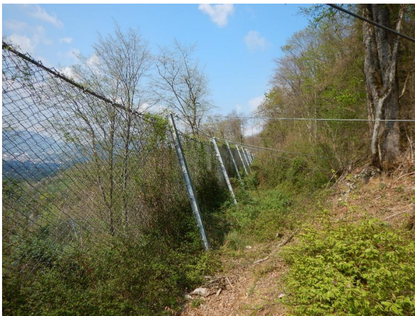
Ecrans pare-blocs (h=6 m) avec rideau de végétation à l'aval (La Buisse – 38)
