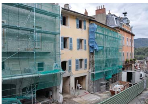
Opérations de réhabilitation conduites par des opérateurs sociaux vers 2010
