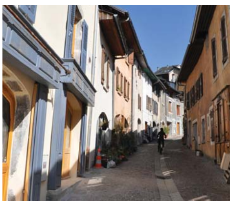
Vue de la rue de la Chaîne progressivement réhabilitée par le privé
