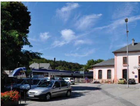
Vue de la gare
