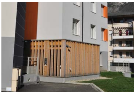
Local vélo en pied d'immeubles
