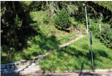
Vue de l'escalier en amont du Grésivaudan
