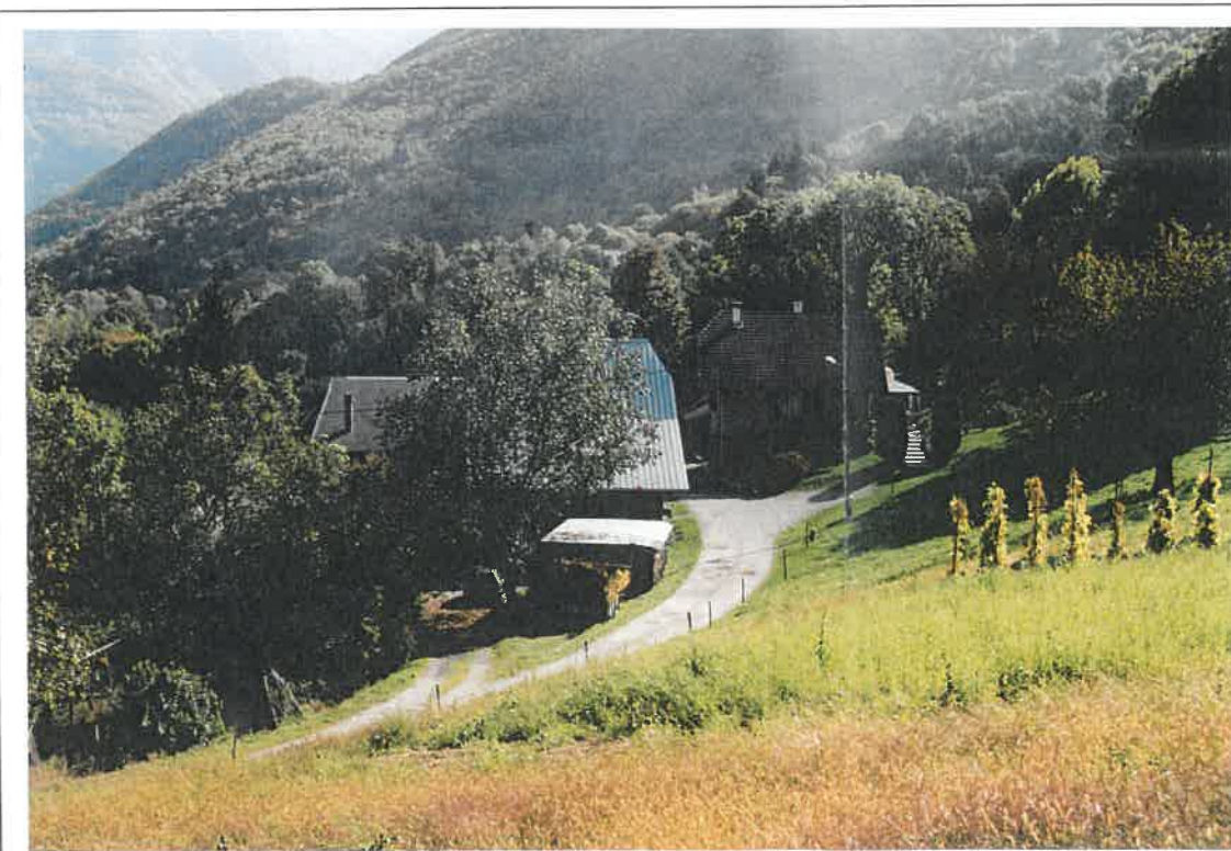
Malgré des efforts sur certains éléments bâtis (croupe et pente de la toiture), l'emprise au sol, les volets, les ouvertures ne permettent pas, en vue rapprochée, une véritable insertion de la construction dans l'architecture vernaculaire.
