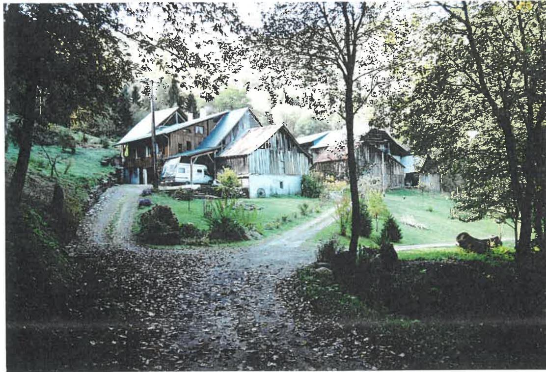
Chez Frison. La remise en état d'une partie des bâtiments s'est particulièrement bien intégrée : les volumes, les pentes de toit ont été respectées. La réhabilitation est seulement trahie par la couleur du bardage.
