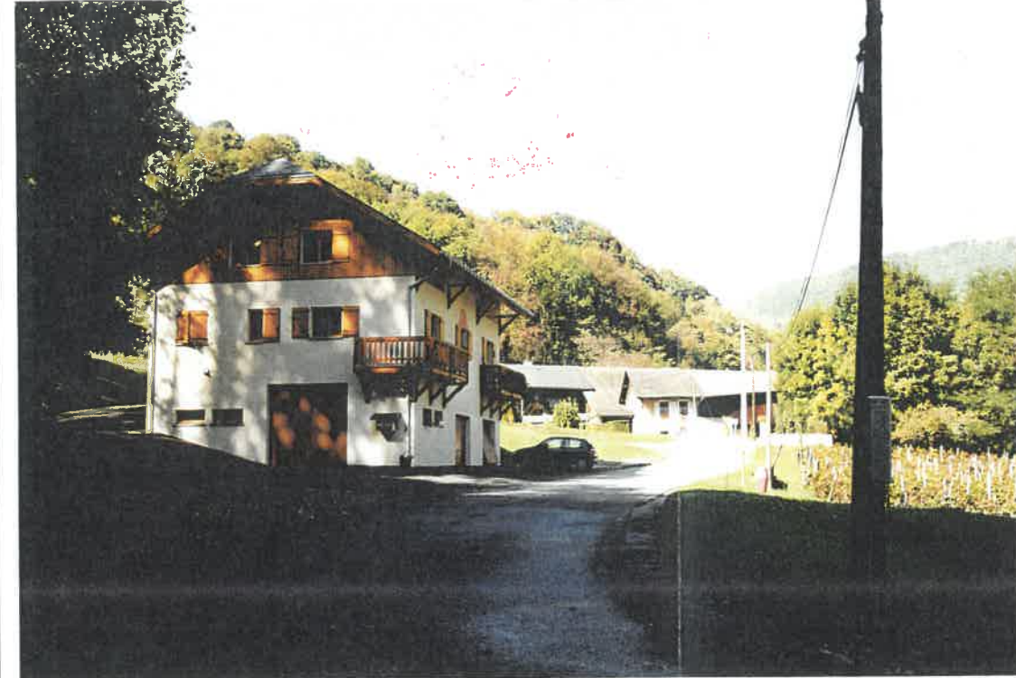
A Saint Arnaud, dans la plaine, une construction récente s'appuie sur les éléments emblématiques de l'architecture locale : enduit clair, bardages verticaux, toiture, gabarit. Ce type de construction correspond toutefois à un modèle que l'on rencontre surtout dans les hameaux plus en altitude (les Bugnons, le Planay) et moins dans la plaine.
