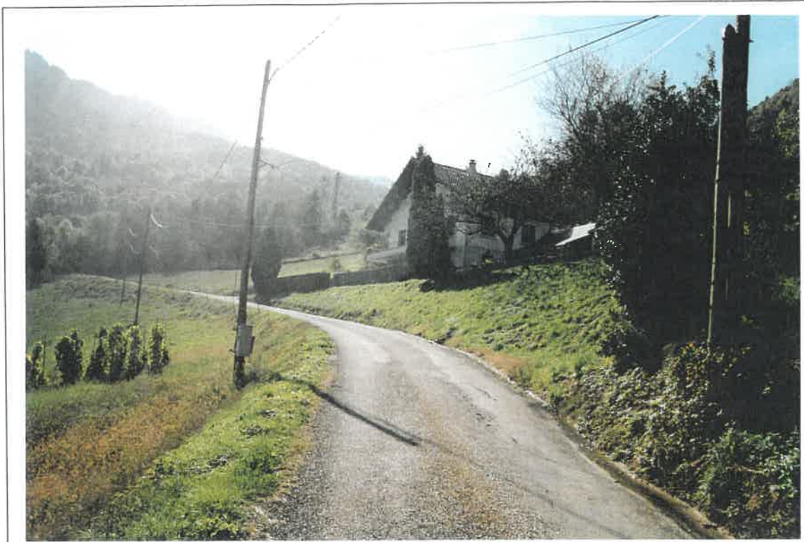
Sur la RD 73, en allant vers le chef lieu : une construction récente esseulée. Si en elle-même, elle n'appelle pas de commentaire particulier, on note toutefois que la toiture (forme et tuiles) s'éloigne des références locales. L'accompagnement végétal (haies de thuyas) est commun.
