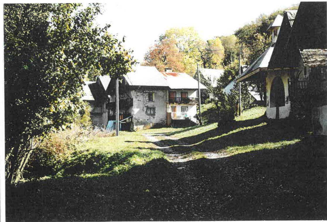
Au Grand Montgilbert, les logements réhabilités sont restés intégrés dans les volumes initiaux et restent cohérent avec le reste de l'espace bâti.
