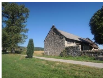
Pignons à redans (à pas d'oiseaux) et toiture en lauzes/tuiles écailles
