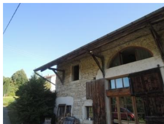
Façades en pierres calcaires, encadrement des ouvertures en pierres taillées
