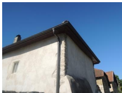
Façades enduites avec chaînage en pierre taillée
