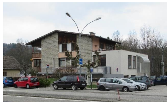
Immeuble mixte avec Mairie – agence postale – logements
