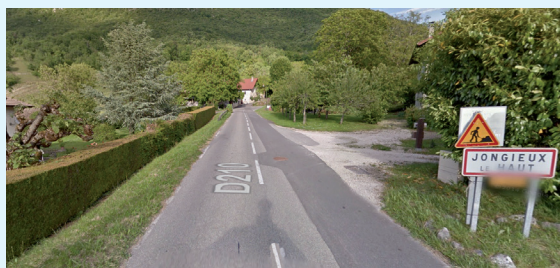
Entrée nord-ouest de Jongieux-le-Haut
