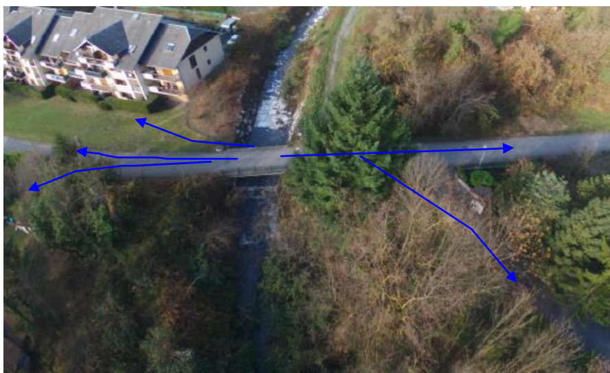
Figure 8 : Débordements possibles en cas d'obstruction du pont du Villard (ETRM)
