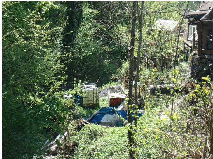
Figure 5 : présence de flottants (cuves, bâches, planches etc.)
