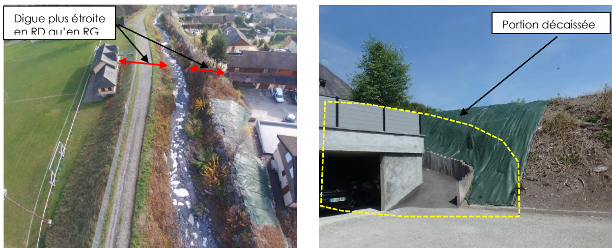
Figure 7 : clichés au droit du lotissement (à gauche source : ETRM)
