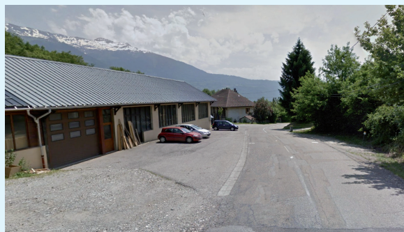
L'entrée nord et son urbanisation lâche
