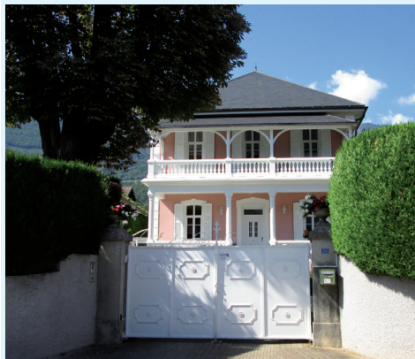
Maison patrimoniale rue de la Mairie
