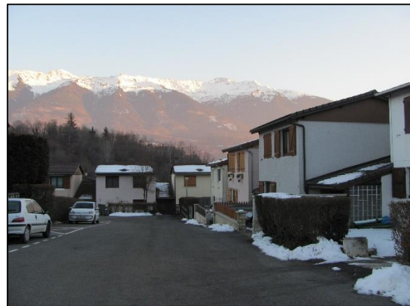
Photo 5 : Habitation du lotissement Pré La Dame
