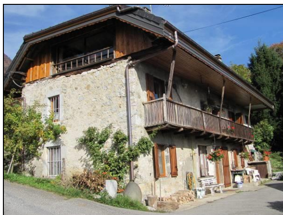
Photo 58 : Façade en pierres apparentes, balcon en bois, grands débords de toit
