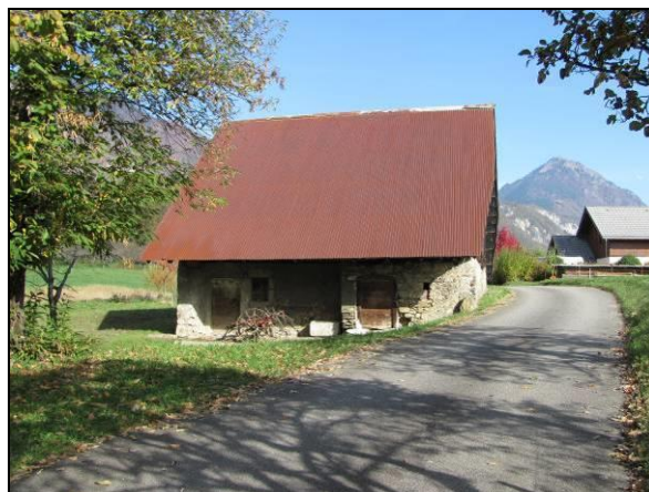
Photo 13 : Bâti ancien de La Plantaz
