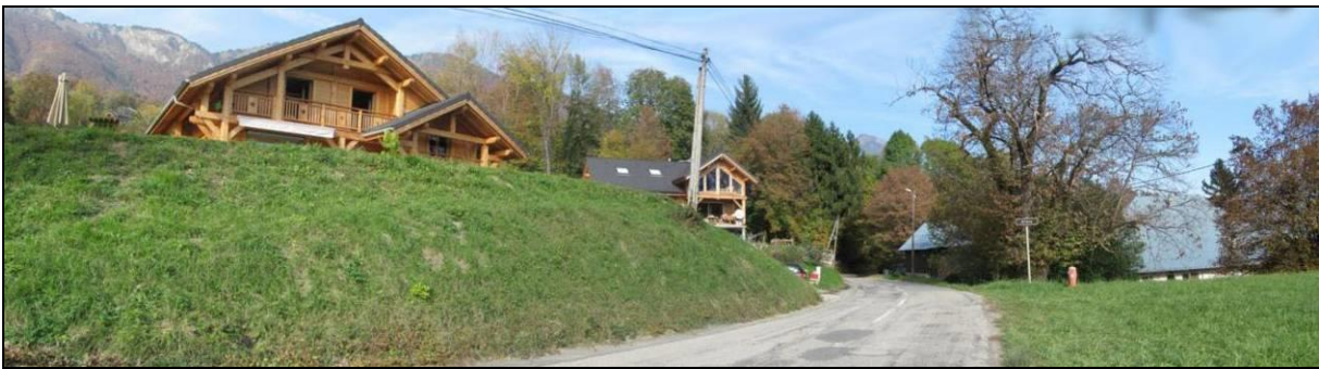
Photo 27 : Constructions neuves d'Alibon
