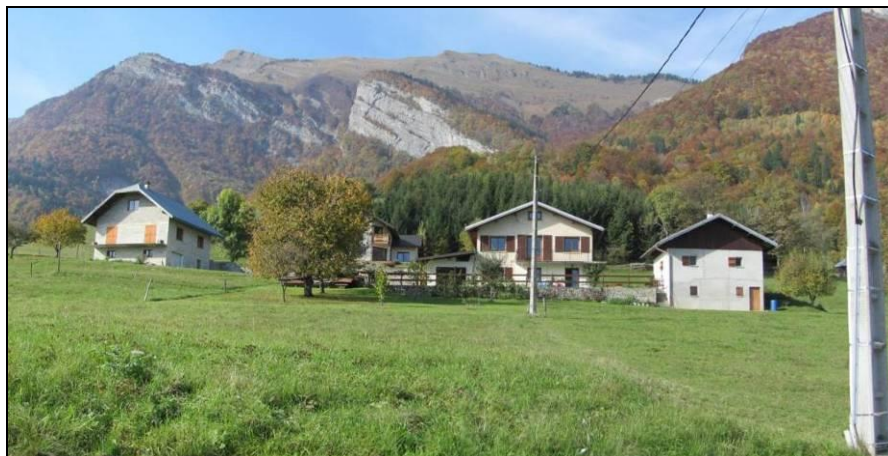
Photo 46 : Constructions récentes en amont du Sauterel
