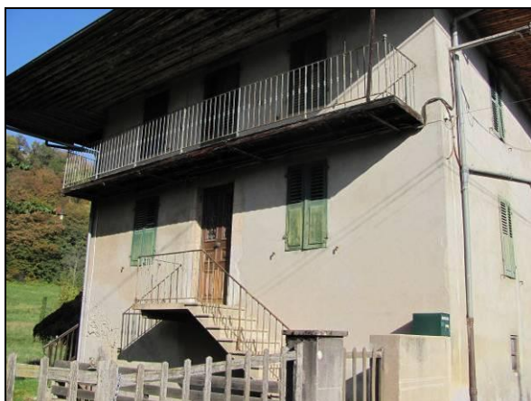
Photo 57 : Balcons en ferronnerie simple, grand débords de toits, volets verts
