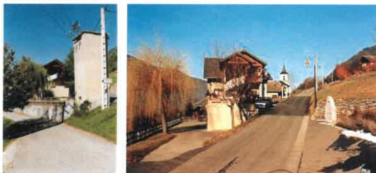
Le poste tour situé près devant mairie avant et après démolition
