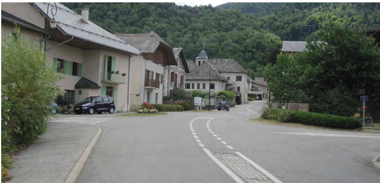
Au croisement avec la rue du Parc ; la chaussée est sinueuse mais large, aux dépens des piétons.
