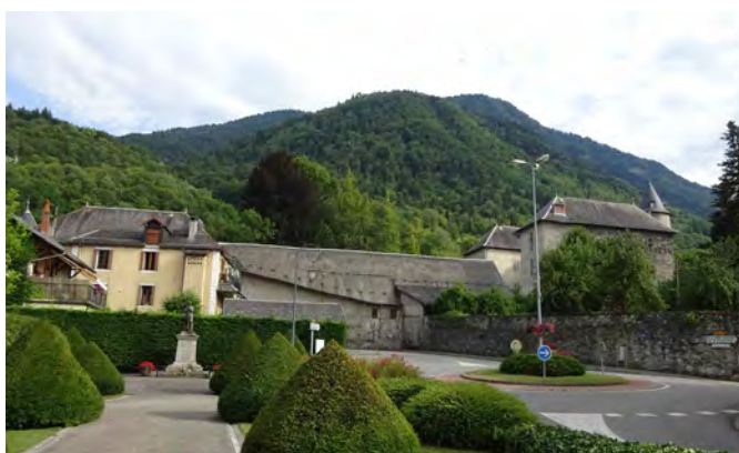
Le château vu depuis le parvis de la mairie
