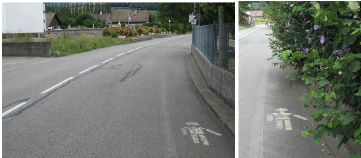
Le long de la route de la Servaz, au nord du bourg : des aménagements peu crédibles pour les piétons.
