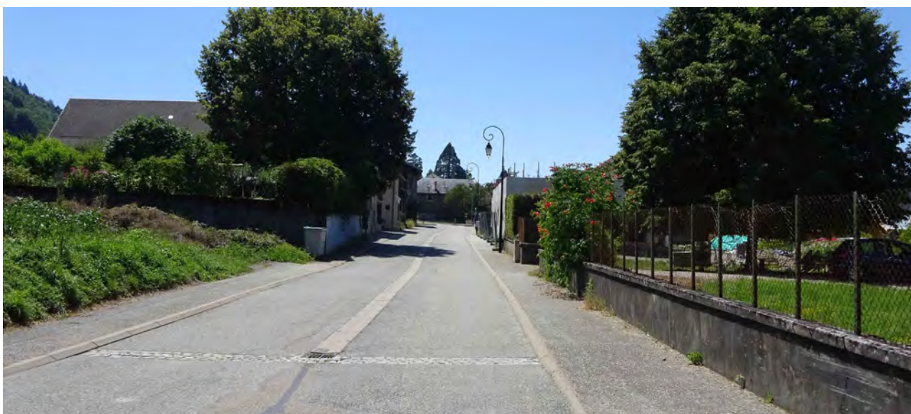
Rue de la Chapelle, après le virage de la route des Berres, le seuil du bourg est bien marqué.
