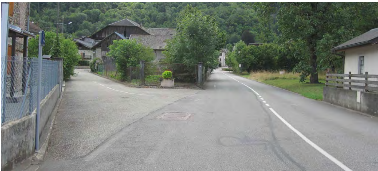
Rue de la Pompe (ancienne route) à gauche. Pas de trottoirs, aménagement encore routier.
