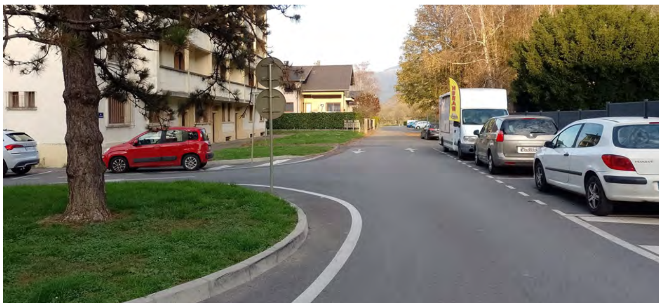
Rue de la République après travaux, vue en 2024 : la rue de la République elle-même n'est pas encore requalifiée, le stationnement y est peu aménagé
