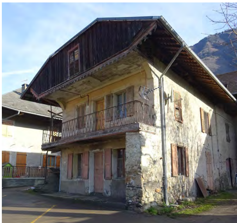
Maison rurale remaniée (fin XIX e siècle ?) à Villard-Dizier
