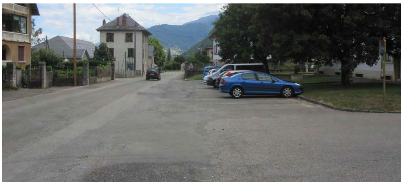
Rue des Écoles, vers l'ouest, vue en 2015 : l'emprise est assez large et permettrait des trottoirs corrects, mais la chaussée est surdimensionnée. Le stationnement en travers crée une discontinuité manifeste des trottoirs, avec un rendement du stationnement pourtant moyen.
