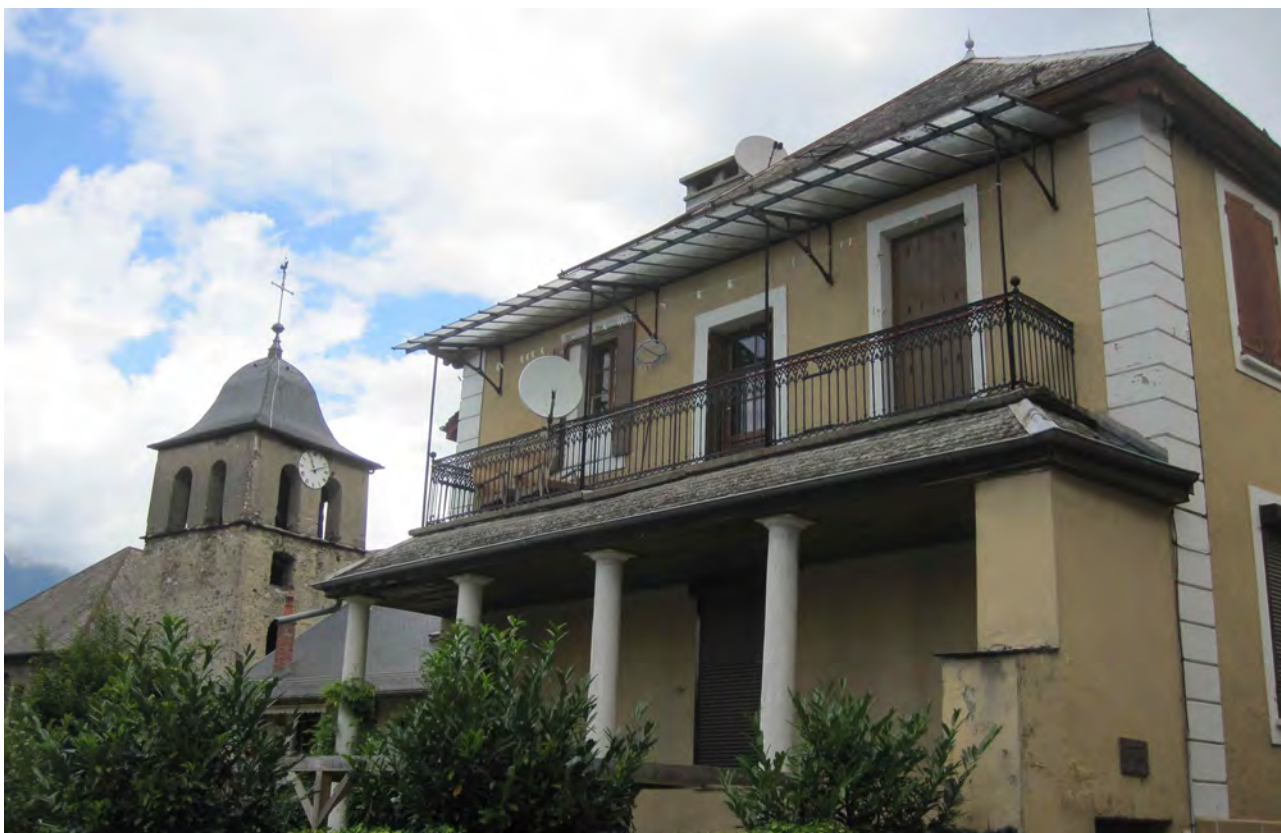
Maison de Gallis, façade sud-ouest
