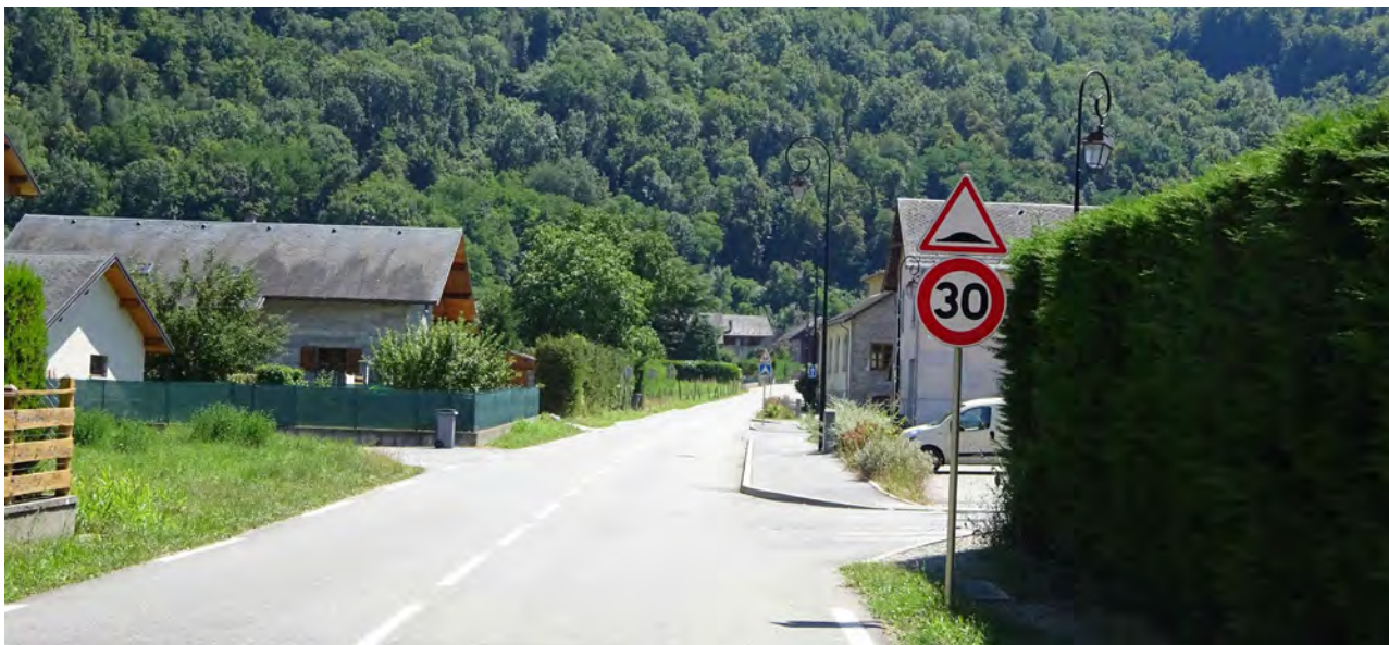
Au croisement de la rue des Écoles : début d'une courte séquence vraiment urbaine avec chaussée rétrécie et trottoirs, d'un côté du moins. La haie végétale masque toute visibilité à droite.
