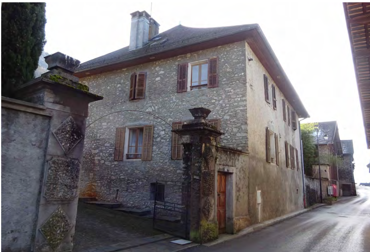
Maison à Villard-Dizier, sur la RD 27
