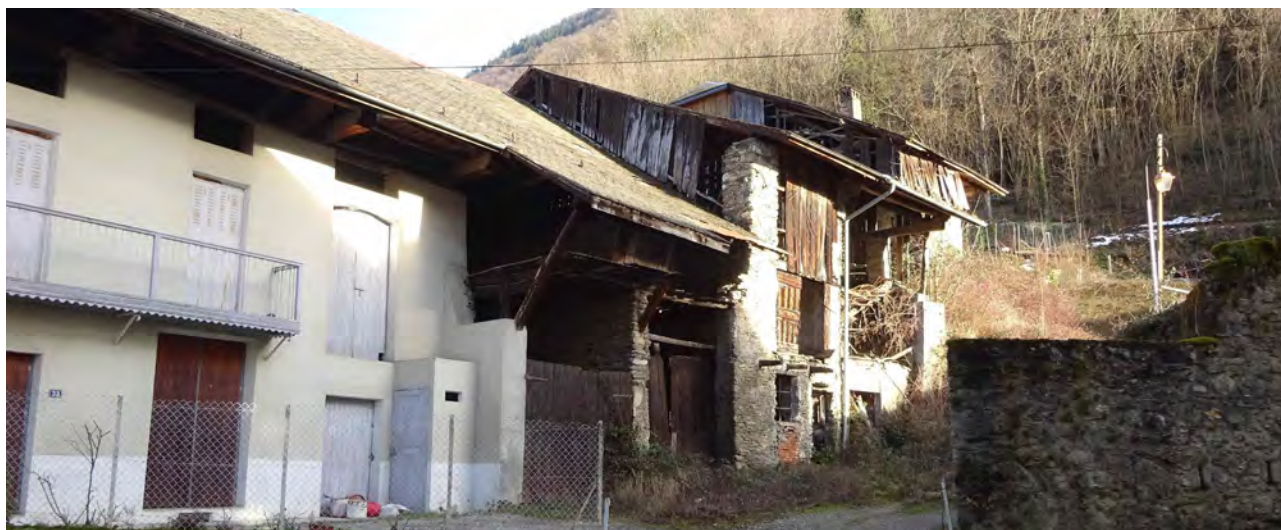
Maisons abandonnées et en ruines en amont du bourg (état en 2016)
