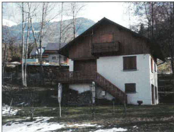
Photo 16 : Perrerette : constructions nouvelles
