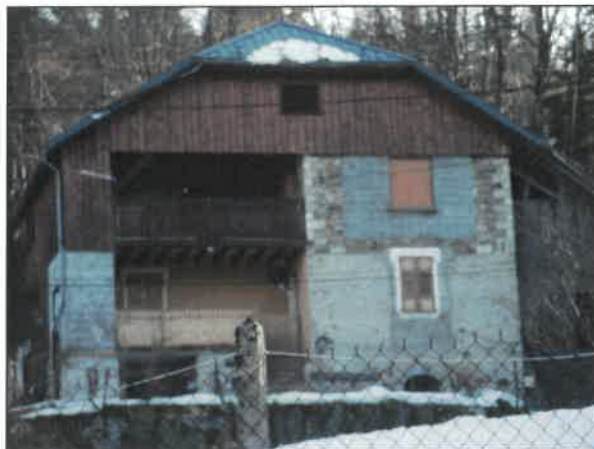
Photo 31 : La Léchère, rénovation
