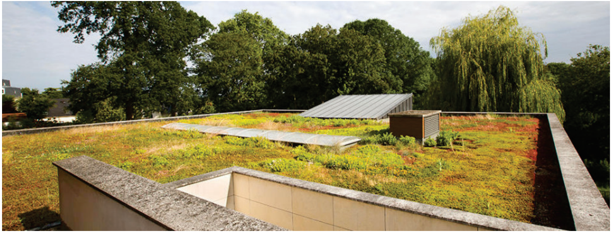
Figure 11 - Exemple d'acrotère sur un toit-terrasse végétalisé
