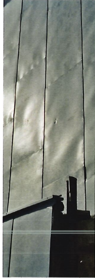
Toitures en tôle plate, à Bonvillard
